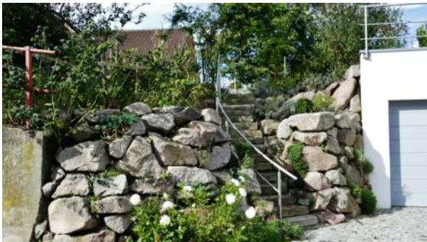
Neue Garten- mauer in der Bucherstraße mit vielen freien Fugen zur Be- siedelung
